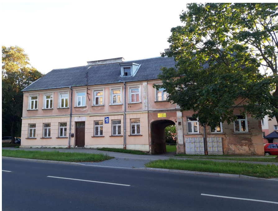
Fot. 13. Zabytkowa kamienica przy ul. Polowej 19
