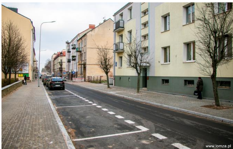
Rysunek 24 Ulica Wiejska po przebudowie. źródło: www.lomza.pl
