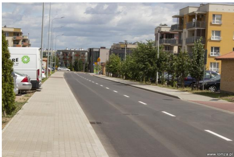
Rysunek 23 Ulica Szmaragdowa po przebudowie. źródło: www.lomza.pl
