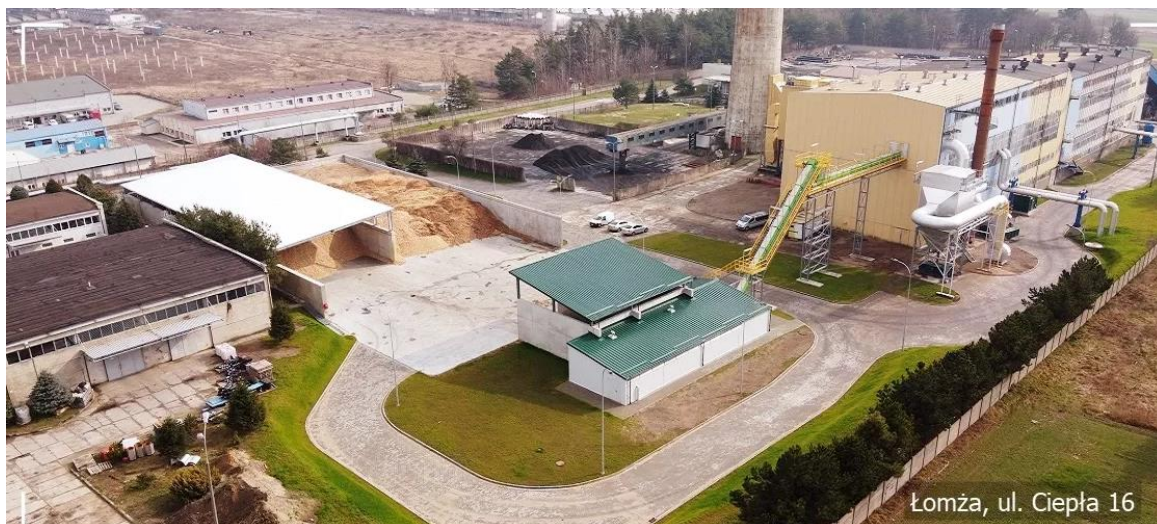
Rysunek 22 Ciepłownia Miejska w Łomży po wybudowaniu nowej instalacji. źródło: www.lomza.pl
