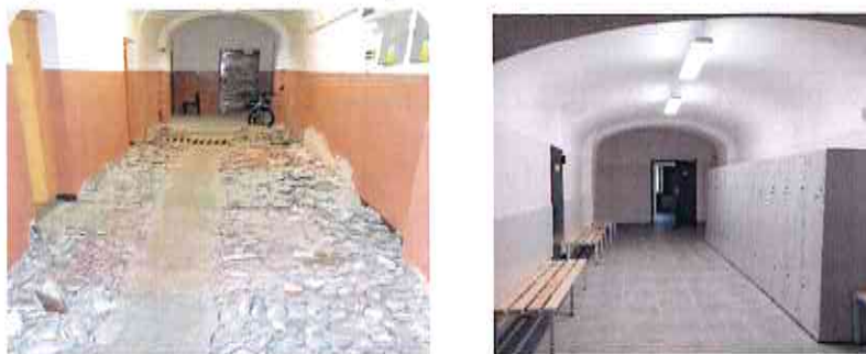
Fot.2. II LO w Łomży przed i po remoncie, fot. Urząd Miasta Łomża
