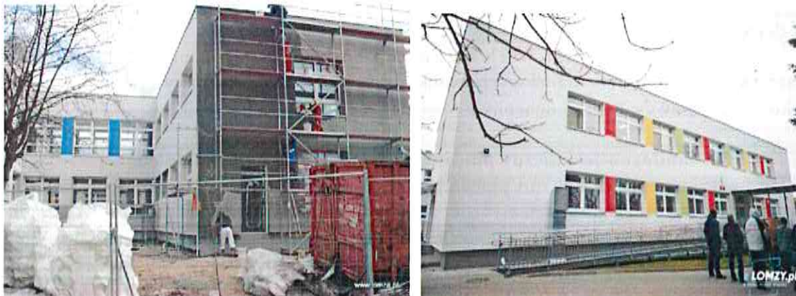
Fot. 2. Prace remontowe w Przedszkolu Publicznym nr 9 w Łomży, fot. Urząd Miasta Łomża
