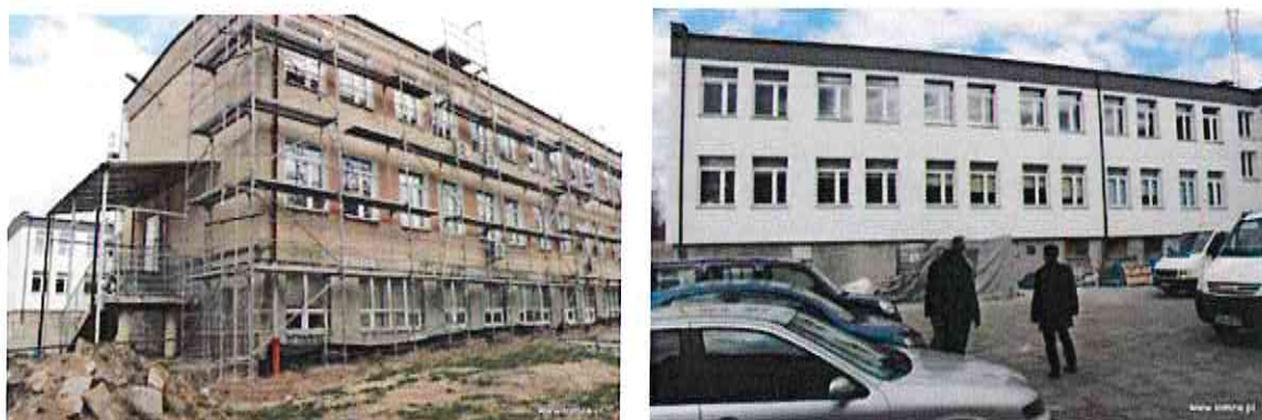
Fot. 5. Termomodernizacja budynku Zespołu Szkół Specjalnych w Łomży, fot. Urząd Miasta w Łomży.
