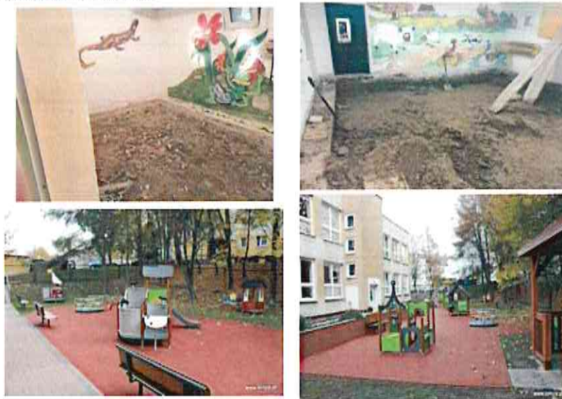
Fot. 1. Prace remontowe w Żłobku Miejskim nr 3 w Łomży, fot. Urząd Miasta Łomża
