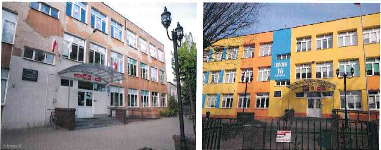
Ryc. 6. Budynek Zespołu Szkół Ekonomicznych przed remontem oraz po wykonaniu termomodernizacji, fot. www.4lomza.pl , PSSE w Łomży.
